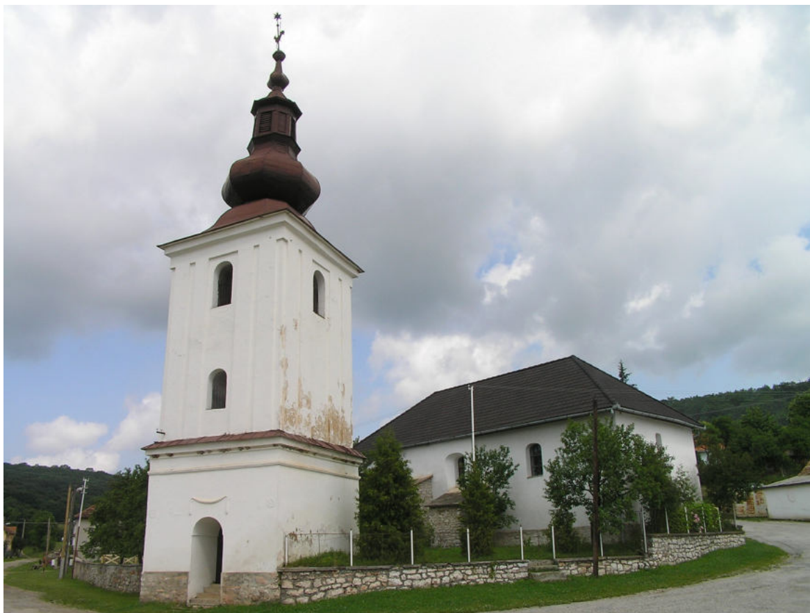
Kostol miestnej reformovanej cirkvi v Silickej Brezovej
