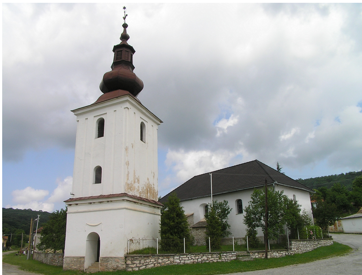
Kostol miestnej reformovanej cirkvi v Silickej Brezovej
